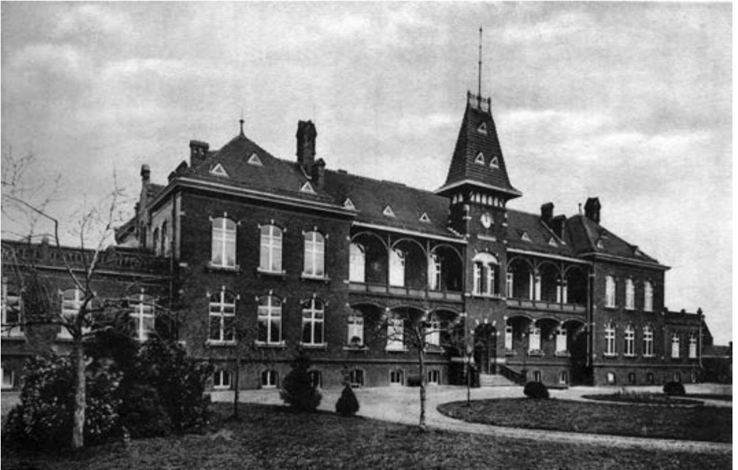
Das Knappschaftskrankenhaus Bardenberg (heute MZ) kurz nach der Fertigstellung, 1904.
